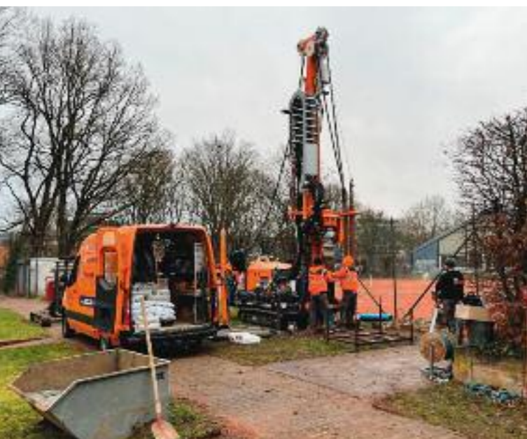
Baustelle während der Bohrung
